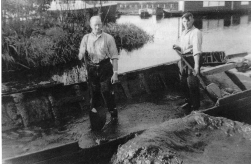
Leo (links) en Piet, met lieslaarzen en houten baggerschoppen hebben hun bok bijna leeg. Deze foto uit het archief van Oud Alkemade verscheen eerder in de Alkmadders. In het onderschrift stond "Ze zien er nog fris uit."
