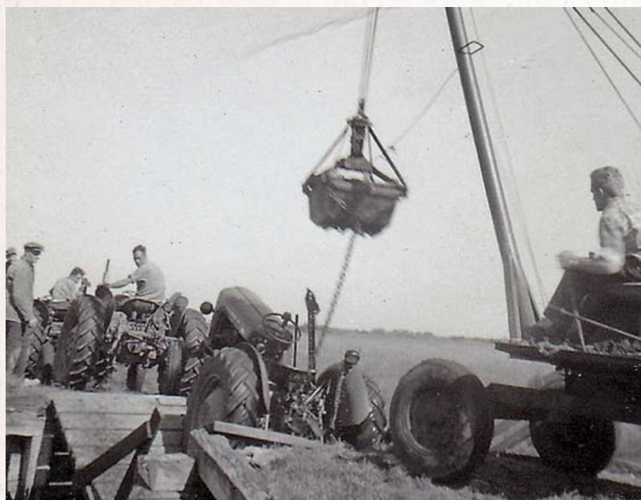
Een trekker is door de brug gezakt en wordt omhoog getakeld door twee andere trekkers (bestuurders Bram en Piet de Mop, links Dammes I).
