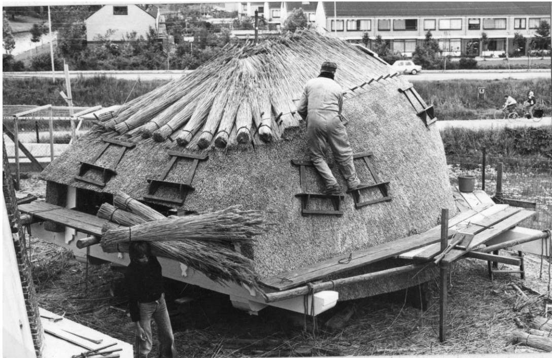
Jan Opdam jr (links onder) en zijn vader (?) aan het werk in Hoofddorp. De kap is op de grond gezet en zal weer met een hijskraan op de molen geplaatst worden.
