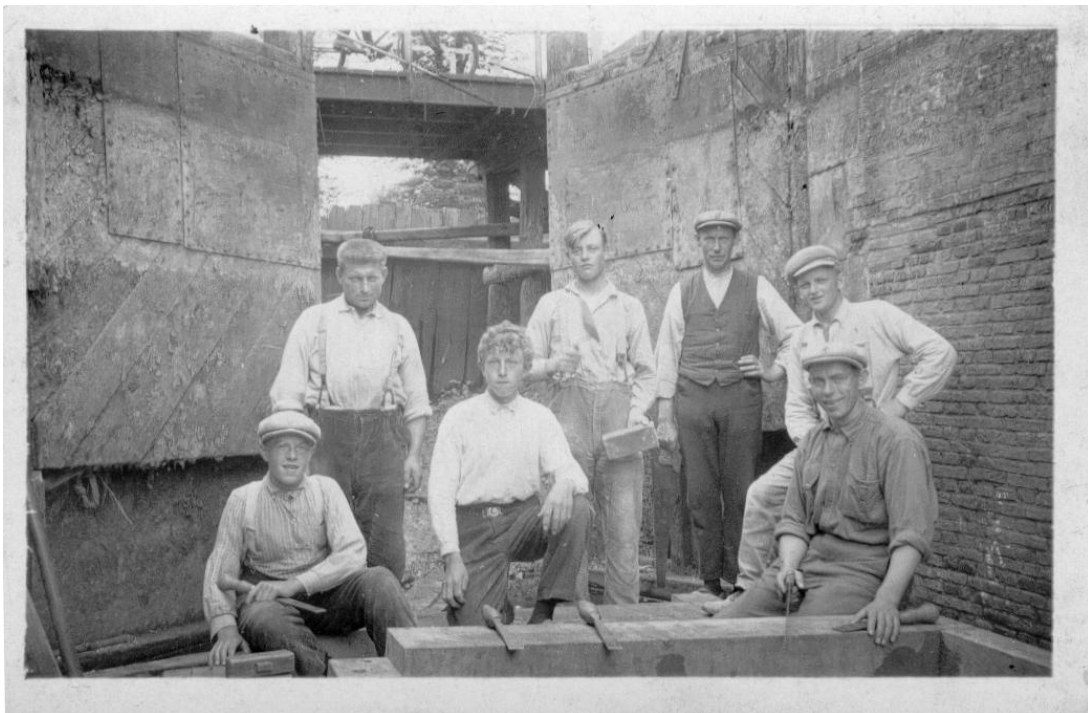
Werk in de sluis in Rijpwetering, uitgevoerd door Roen Vrijburg, molenmaker en aannemer uit Oud Ade. Voor deze herstelwerkzaamheden werd de sluis 'drooggelegd'. Achter v.l.n.r. Gerrit van Leeuwen (Oud Ade). Piet Olijerhoek (Oud Ade). Roen Vrijburg, uitvoerder (Oud Ade), en Koos Jansen (Hoogmade); vóór: Jan Verhaar (Kaag), Kees Colijn (Hoogmade) en Dirk Straathof (Hoogmade).
